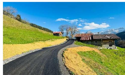
**6. Descriptif du projet** Fouille drainante avec chaille 30/60 mm, drainage Ø 200 mm, longueur 400 ml, coffre de route longueur 420 ml, largeur 3 ml, épaisseur 40 cm, fourniture et mise en place de revêtement bitumineux, ACT 16 N, épaisseur 7 cm.
